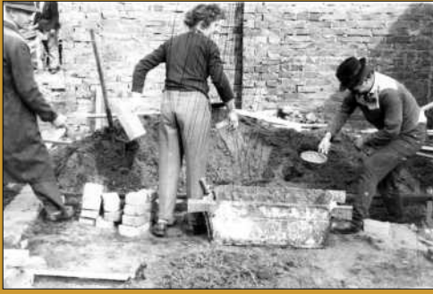
Vidámpark építése társadalmi munkában 1959 nyarán
